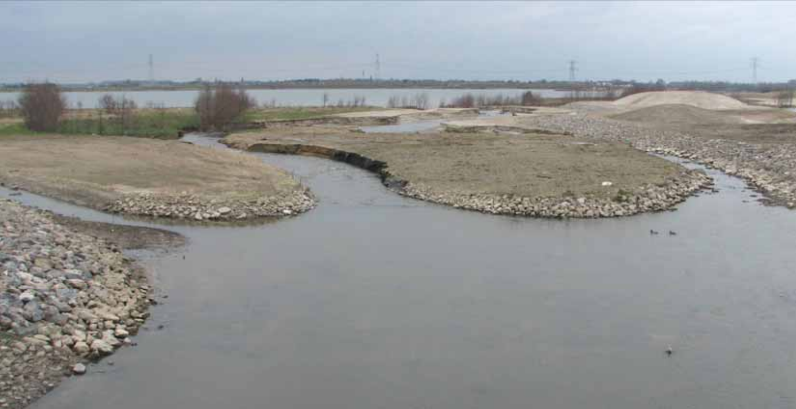
De voormalige grindvlakte in de zuidoosthoek is eind 2007 afgewerkt tot een overlaat-delta, waarover een deel van het water uit de Geleenbeek kan afstromen.
